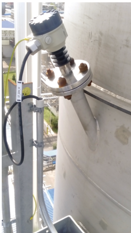
Tartály oldalába ferdén szerelt NIVOCAP távadó
