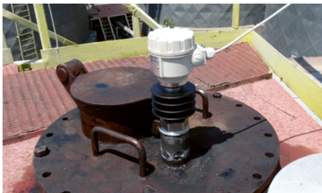
Hűtőbordával ellátott WHS sorozatú PiloTREK készülék 160°C hőmérsékletű bitumen szintmérésénél
