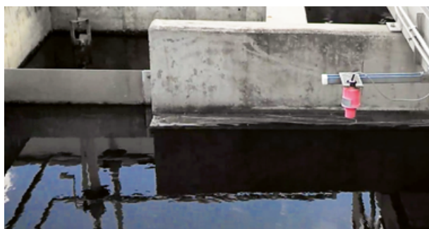
Ultrahangos folyadékszint mérés nyitott tárolóban
