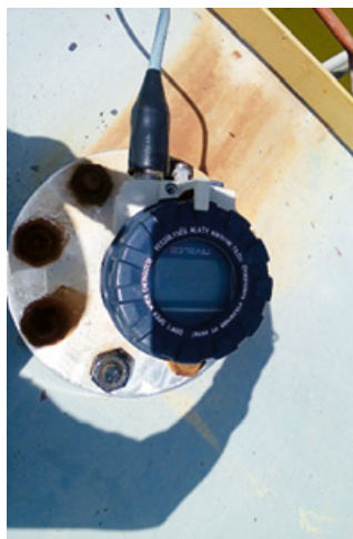
Szabadtéri tartályon elhelyezett NIVOTRACK távadó helyi kijelzéssel
