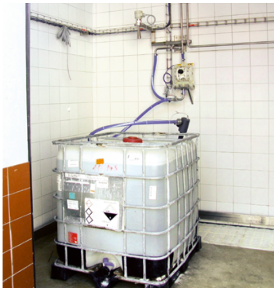
Műanyag tartályban tárolt folyadék szintmérésére a tartályon kívül felszerelt készülékkel
