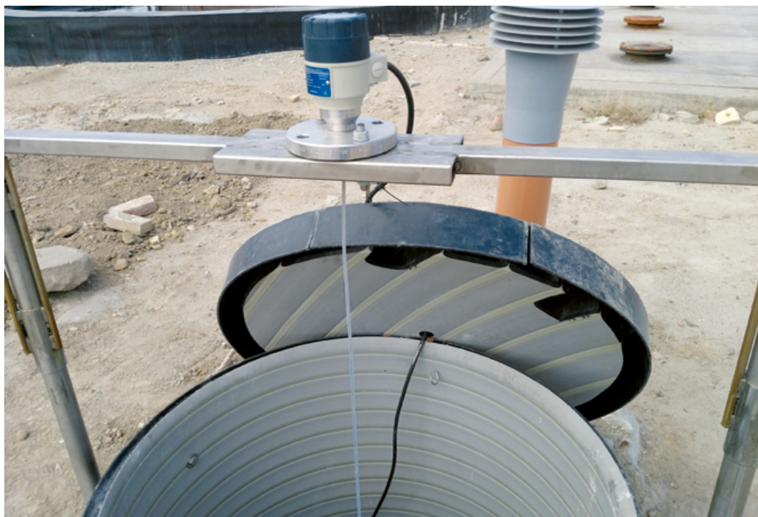
MicroTREK HH sorozatú készülék gyógyszeripari technológiai berendezésen Karimára szerelt MicroTREK szinttávadó földalatti gyűjtőtartályon
