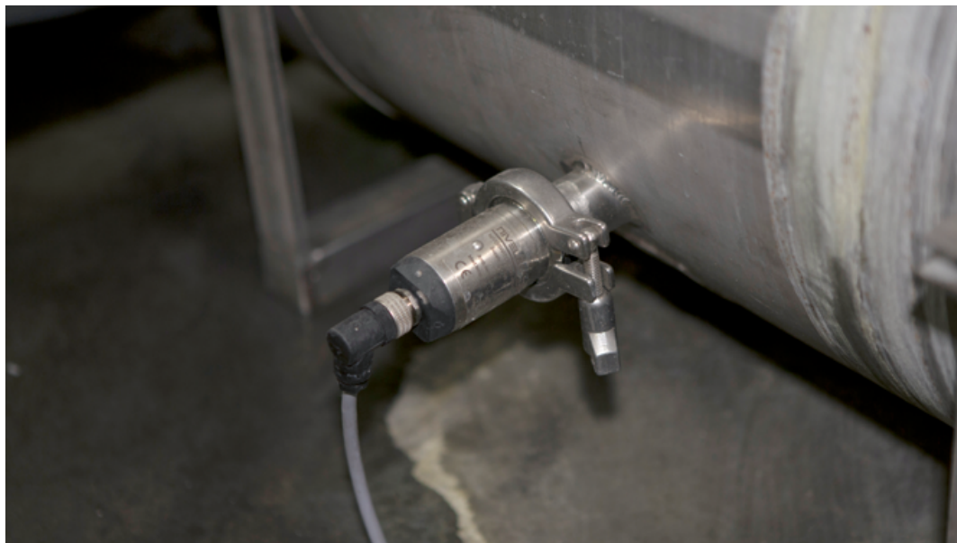
NIVOSWITCH mini kompakt rezgővilla folyadék tartályon. A technológiai csatlakozó TriClamp rendszerű
