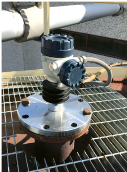
Karimára szerelt PiloTREK WJ sorozatú készülék, szabadtéri tartályon
