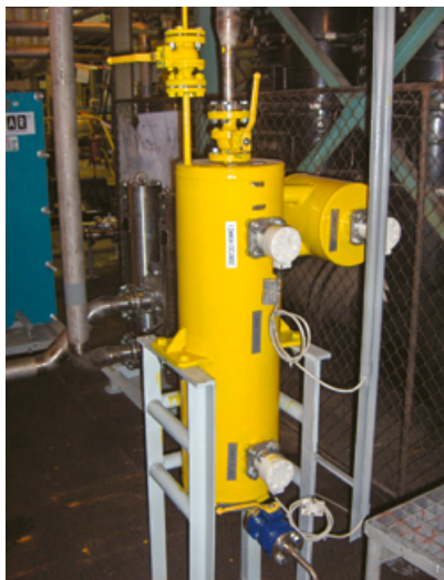
Alsó és felső határ jelzése egy-egy NIVOMAG MK készülékkel
