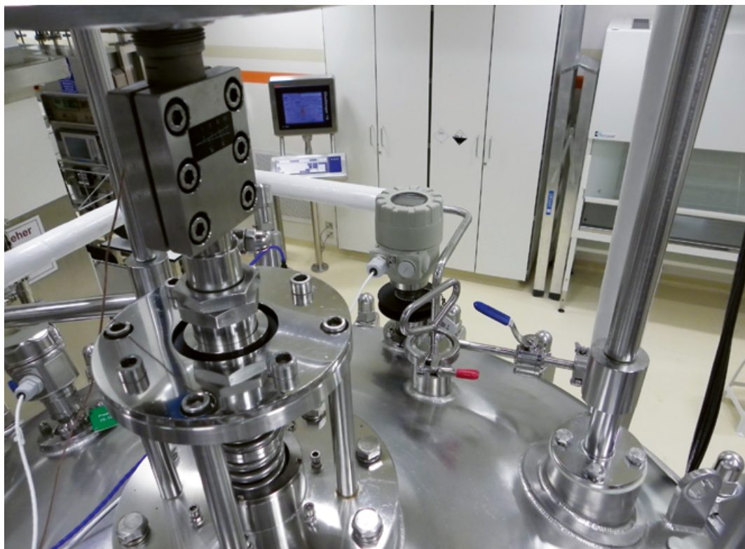
MicroTREK HH sorozatú készülék gyógyszeripari technológiai berendezésen Karimára szerelt MicroTREK szinttávadó földalatti gyűjtőtartályon
