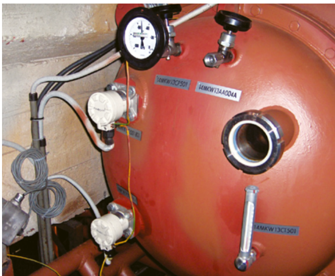
Alsó és felső határ jelzése egy-egy NIVOMAG MK készülékkel
