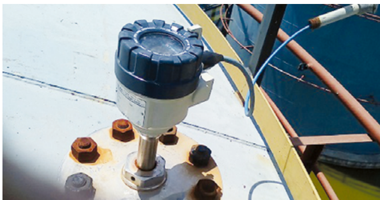
NIVOTRACK szinttávadó, tartályra szerelve
