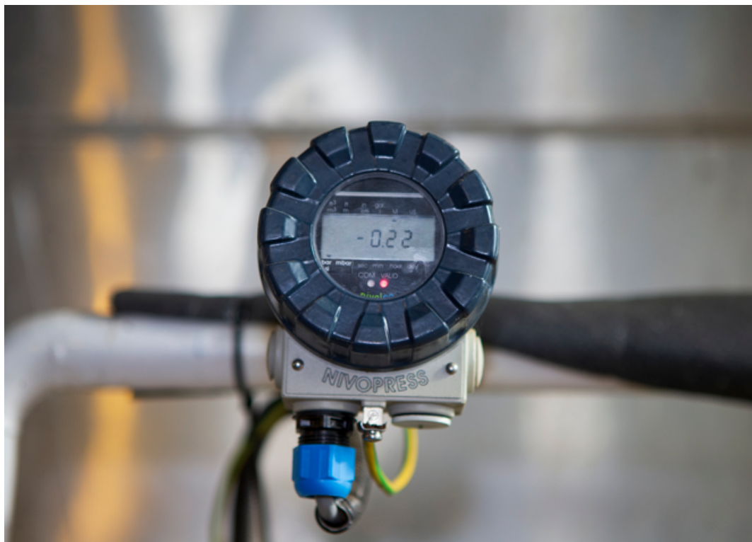
A NIVOPRESS D távadó beépített kijelzője
