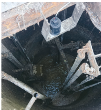
Hűtőbordával ellátott WHS sorozatú PiloTREK készülék 160°C hőmérsékletű bitumen szintmérésénél
