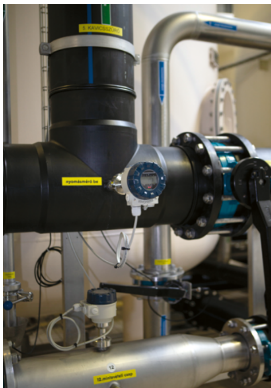
A NIVOPRESS D távadó beépített kijelzője
