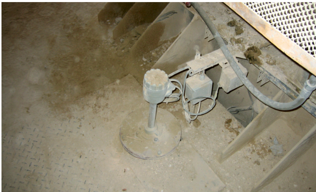
Poros tartály szintmérése EchoTREK STD sorozatú készülékkel
