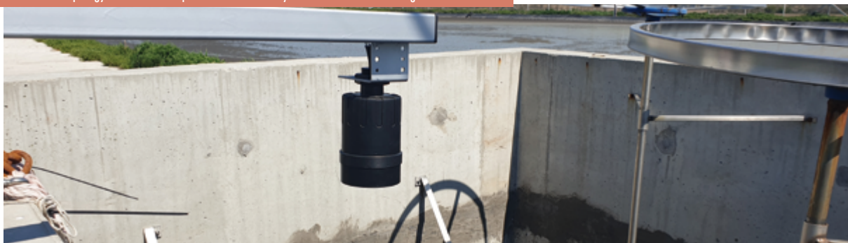
Állattartó telep trágyatároló medencéjének szintmérése EasyTREK SPA-360-4 ultrahangos szinttávadóval
