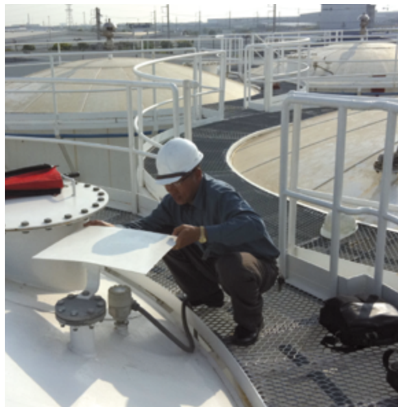
Vegyszertároló tartályok szintjének mérése MicroTREK irányított mikrohullámú szintjeladóval
