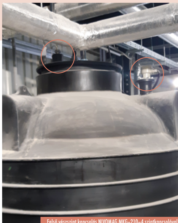
Felső vésszint kapcsolás NIVOMAG MKG-210-4 szintkapcsolóval
