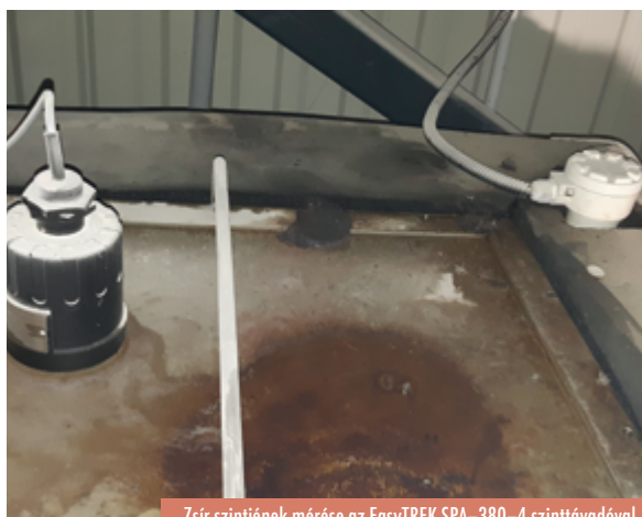
Zsír szintjének mérése az EasyTREK SPA-380-4 szinttávadóval
