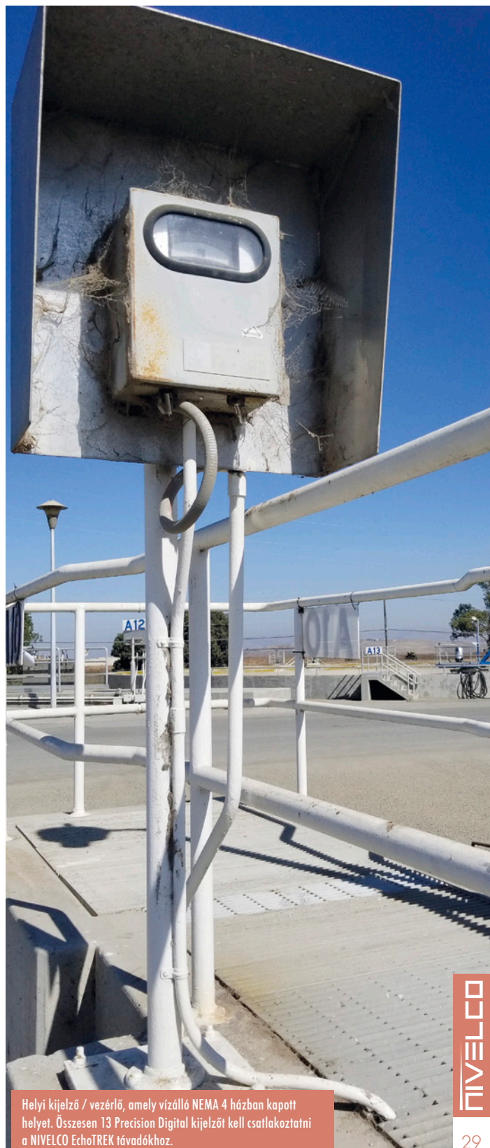
A képen azt a területet láthatjuk, ahol az EchoTREK távadók a föld alatti csatornába kerülnek. A rács az üzemi személyzet áthaladására szolgál, a villanymotorok pedig az alul lévő szivattyúk számára biztosítják a meghajtást.
