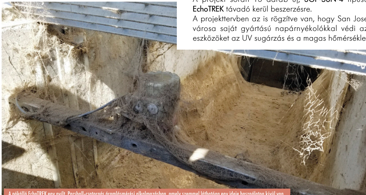
A pókálló EchoTREK egy nyílt, Parshall-csatornás áramlásmérési alkalmazásban, amely szemmel láthatóan egy ideje használaton kívül van
